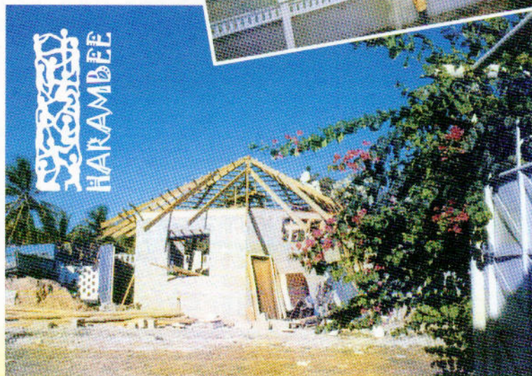
Alcuni momenti della costruzione a Dar, della "Capanna della Multimedialità"
